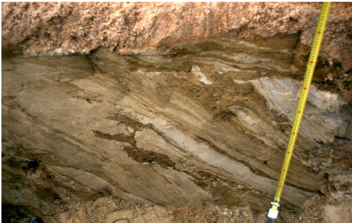
Abb. 102: Gestauchte saalezeitliche Sedimente im Liegenden ungestörter weichselzeitlicher Vorschüttssande (Erdgastrasse zwischen Egisdorf und Töpchin)
