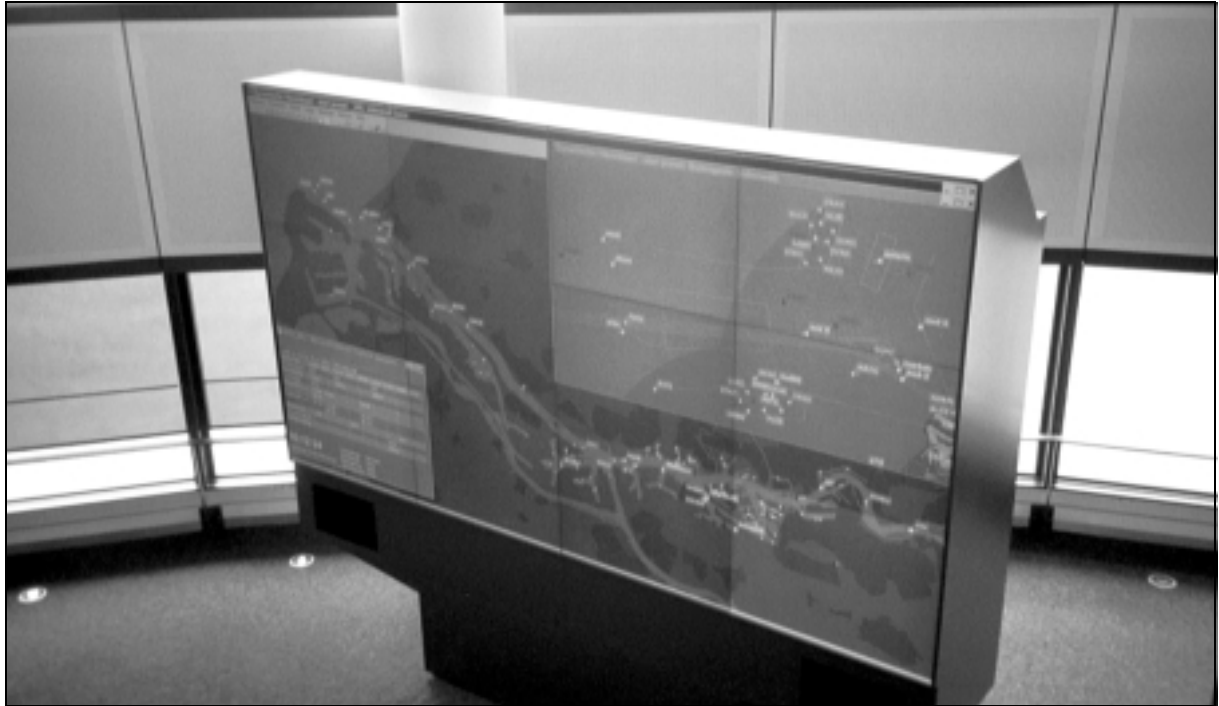
Video wall met de Dynamische Havenkaart in controlekamer van het Haven Coördinatie Centrum.
